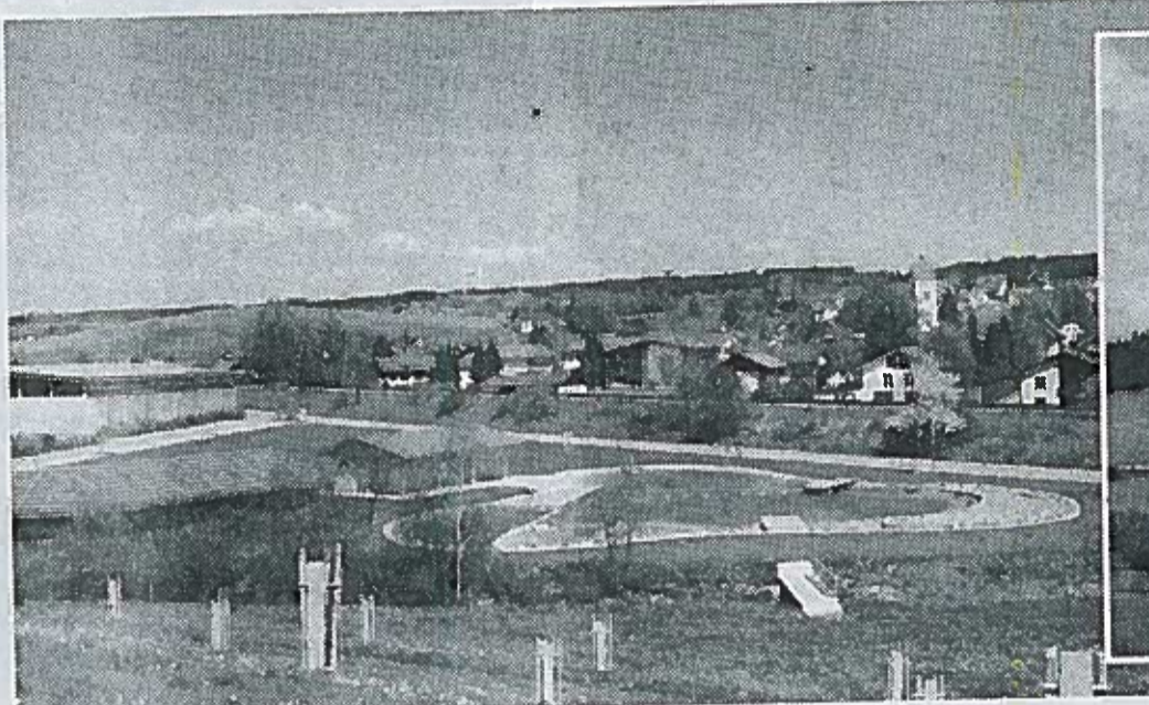
Nella foto, l'impianto di depurazione delle acque di Wildpoldsried
