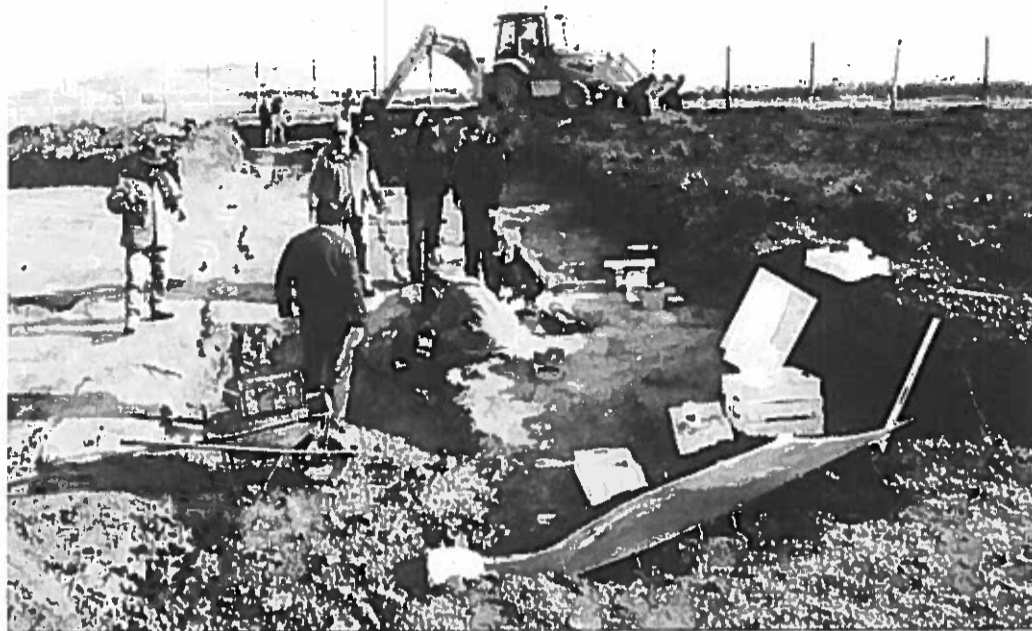
Sorpresa Addetti ai lavori durante le operazioni di scavo nel parco di Vulci
