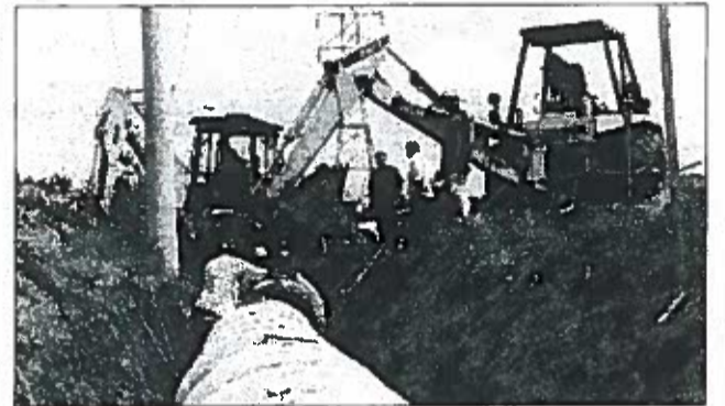
Tarquinia Lavori del Consorzio di bonifica
